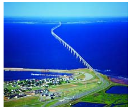
(en haut) Southampton Port de la Associated British Ports. (en bas) Pont de la Confédération entre le Nouveau-Brunswick et l'Île-du-Prince-Édouard.
